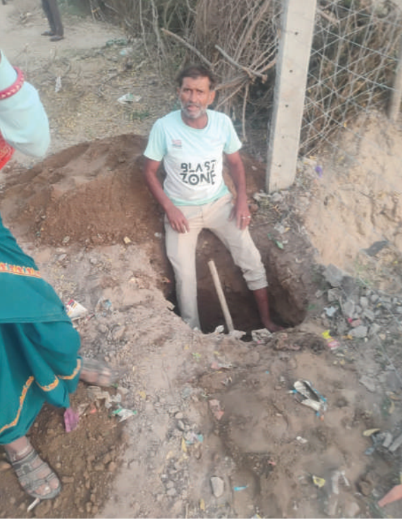
निवाई। श्योसिंहपुरा में अवैध पेयजल कनेक्शन के लिए गड्ढा खोदते हुए ग्रामीण।
